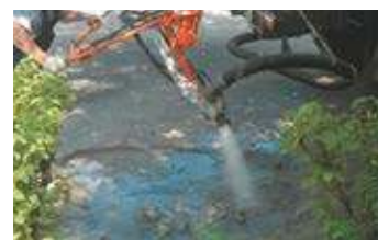
Промывка ямы водой
