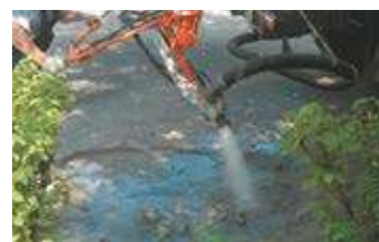
Промывка ямы водой
